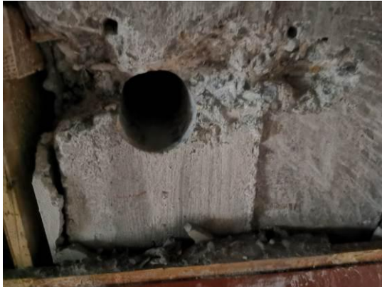
附照 25 取芯检测混凝土强度
