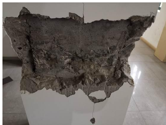
附照 24 开凿检测柱钢筋配置
