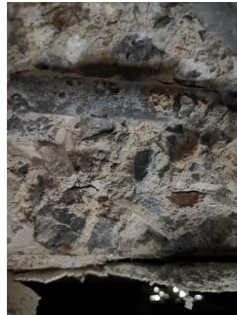
附照 26 开凿梁底检测钢筋配置
